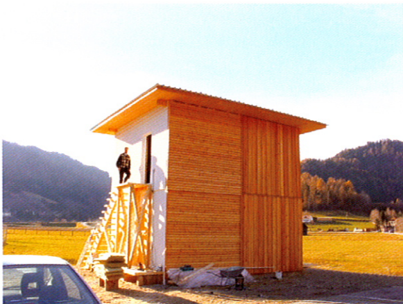
Bâtiment d'essais - KLH Massivholz GmbH Katsch/Mur
