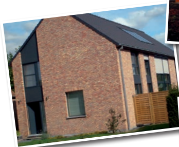
Maison passive à Comines Architecte : Joseph Demuyser
