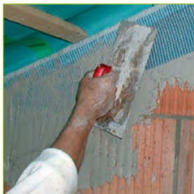
Etanchéité à l'air entre freine-vapeur et mur en maçonnerie (photo : Iso-proc)
