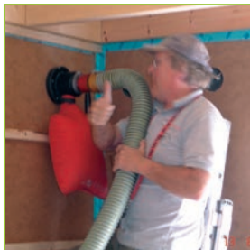
Soufflage de cellulose dans une ossature bois (photo : Régis Verhosel)
