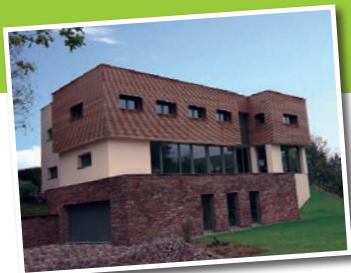
Maison passive à Stavelot Architecte : Architectes Team Marc Steffens Photo : Architectes Team Marc Steffens
