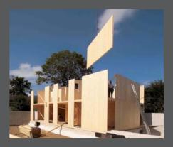
expérimentée dans la construction bois associé à la grande précision d'usinage garantissent un montage et une mise hors d'eau très rapide, avec un niveau de qualité élevée tout en respectant l'aspect individuel de chaque projet.
