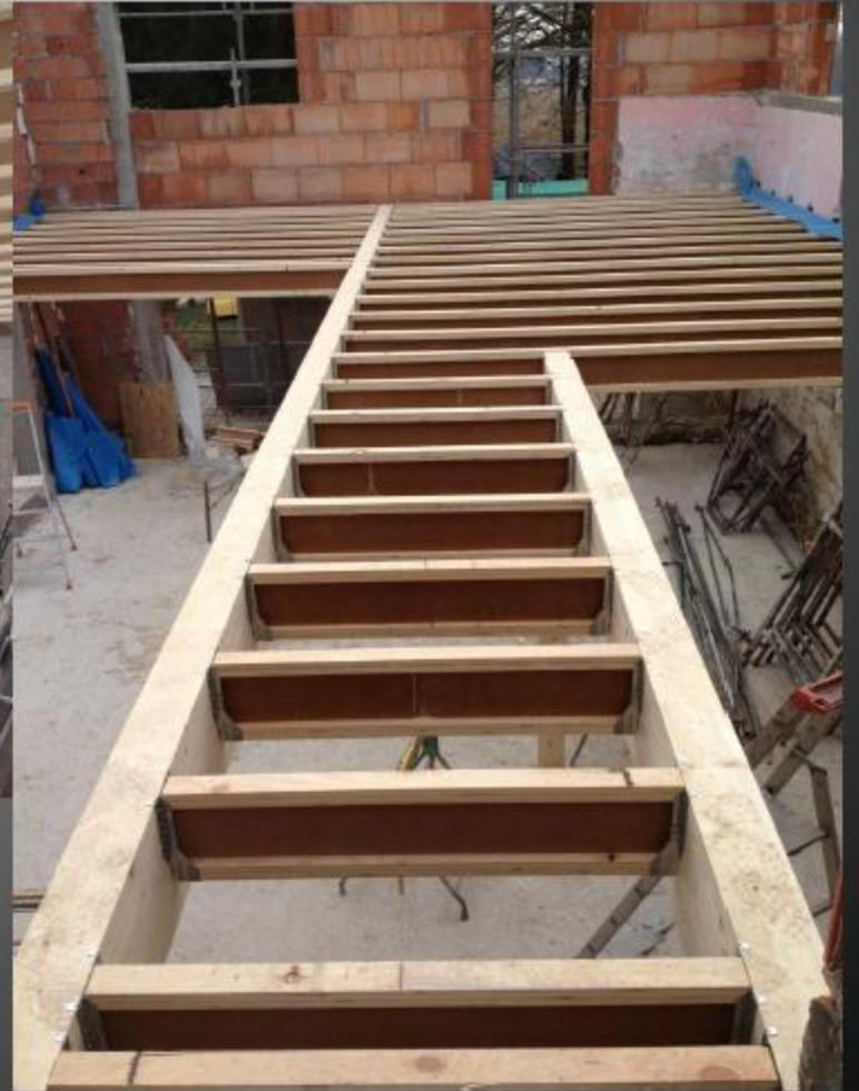
Plancher intermédiaire sur cuisine réalisé en poutre I bois.
